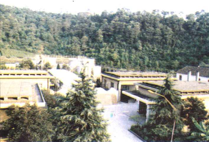
①通讯电缆生产车间
