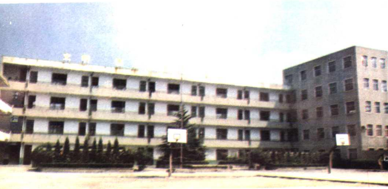
浦沿初级中学教学楼
