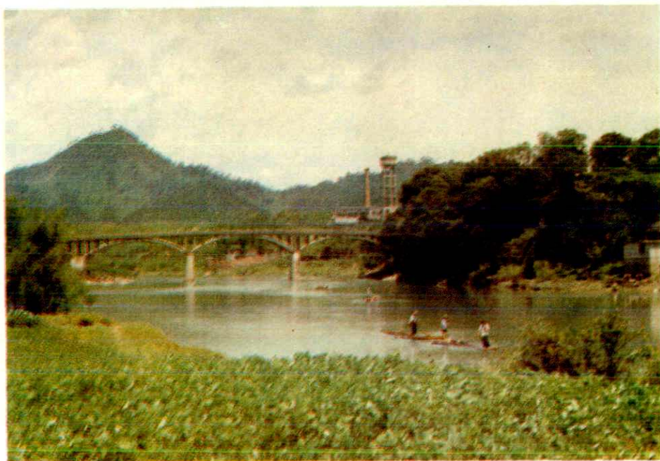
图为西津大桥
