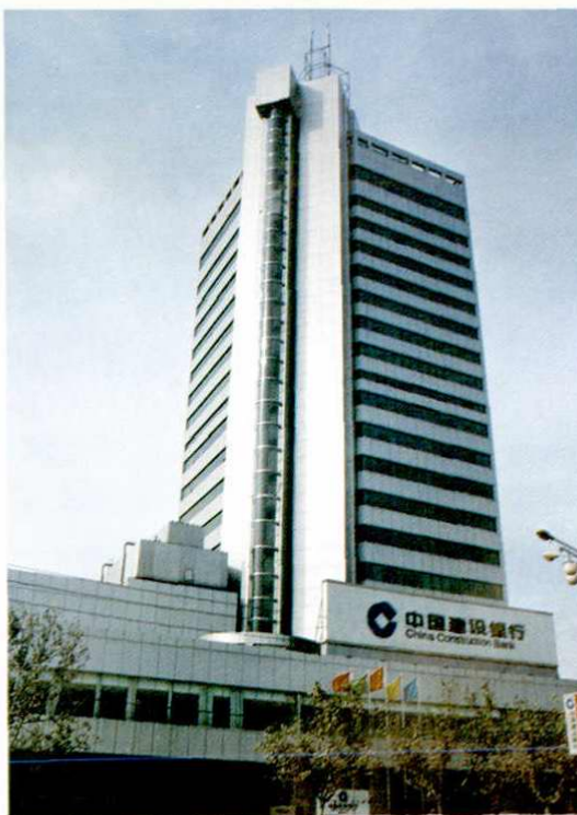
中国建设银行咸阳分行办公大楼
