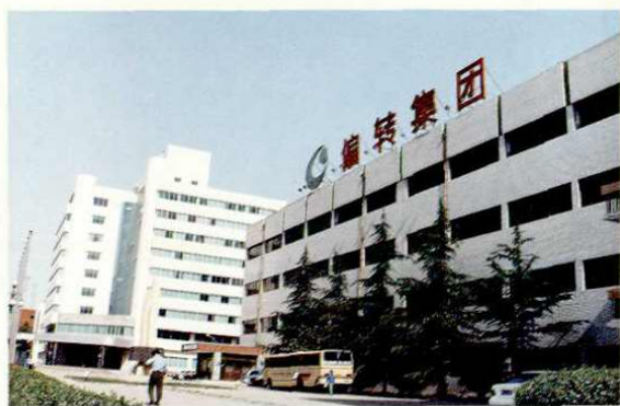
咸阳偏转集团科技大楼
