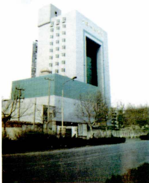
中国人民银行咸阳分行办公大楼
