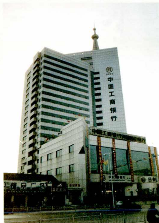
中国工商银行咸阳分行办公大楼
