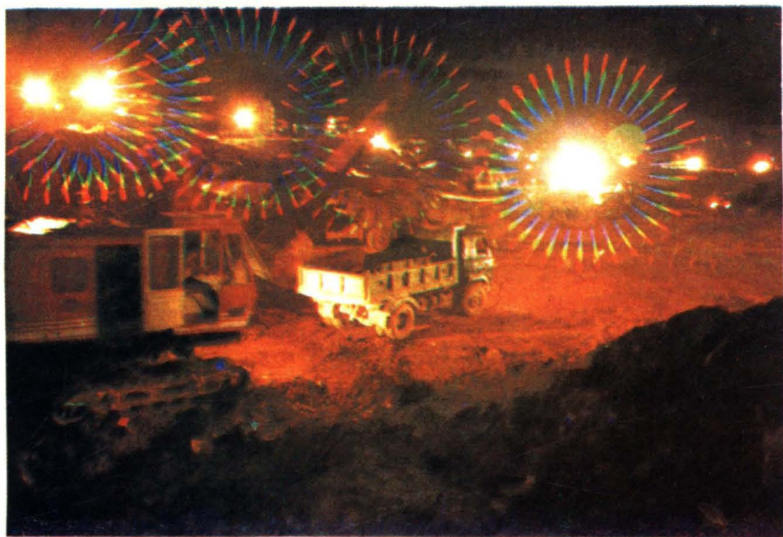
建设中的厦门经济特区湖里加工区
