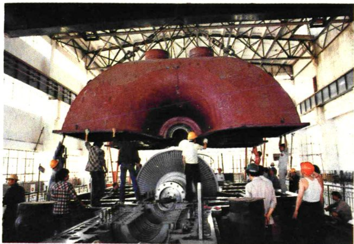
10万千瓦汽轮机扣大盖
