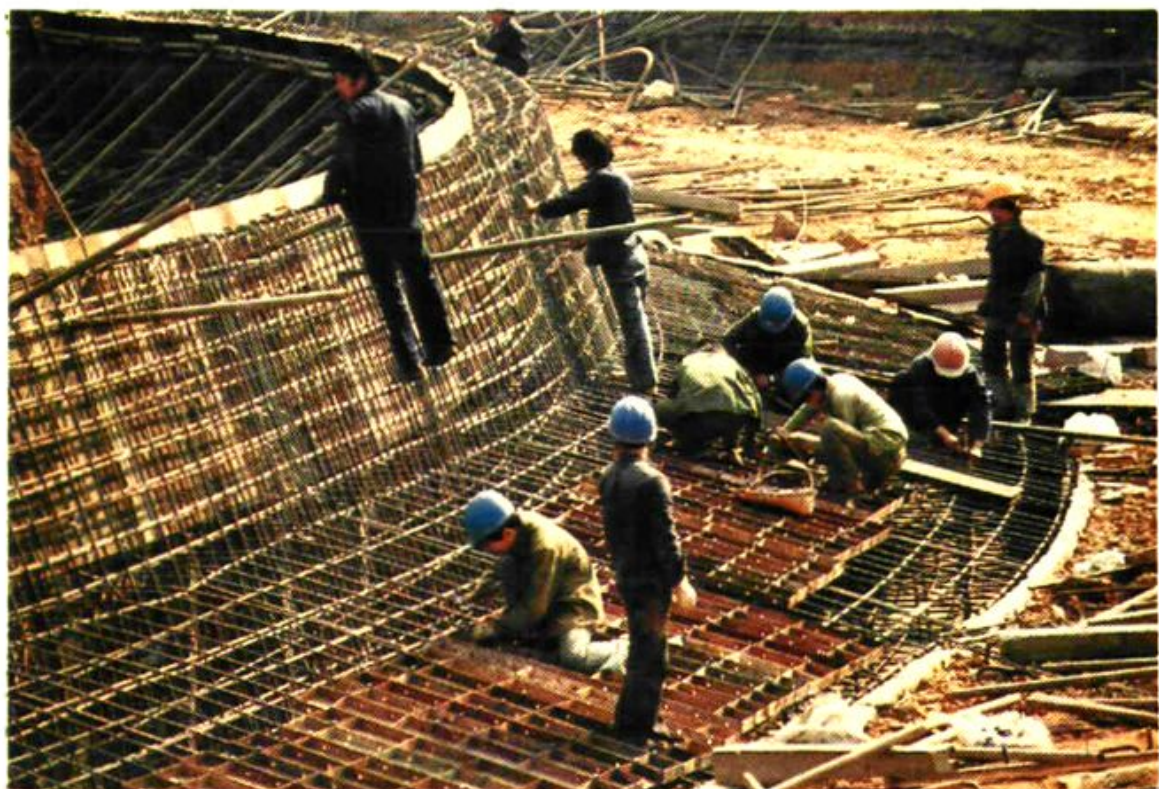
1500M 2 双曲线横流式自然通风冷却水塔施工
