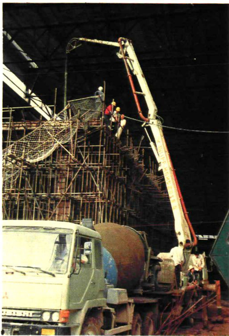
混凝土泵车在作业，浇汽机基础
