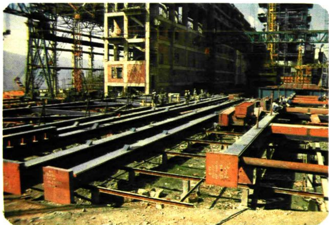
410吨/时锅炉钢架组合
