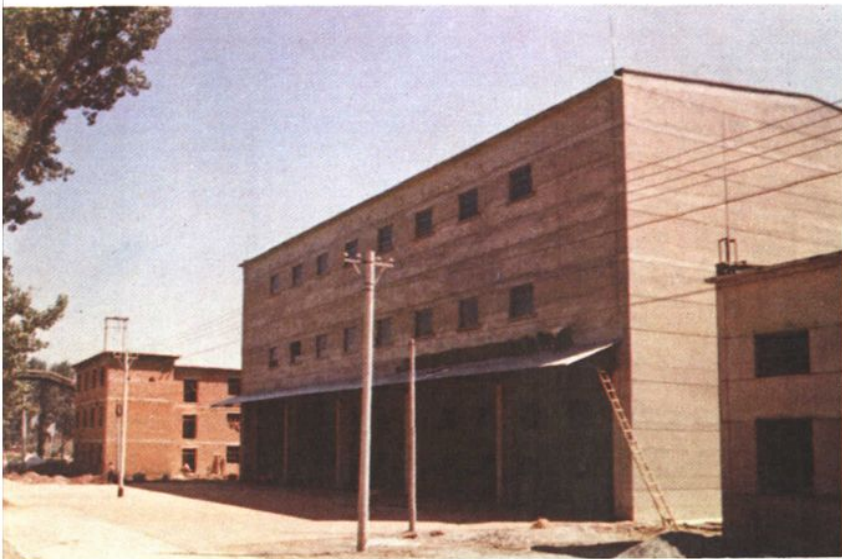
中试厂保护渣车间厂房
