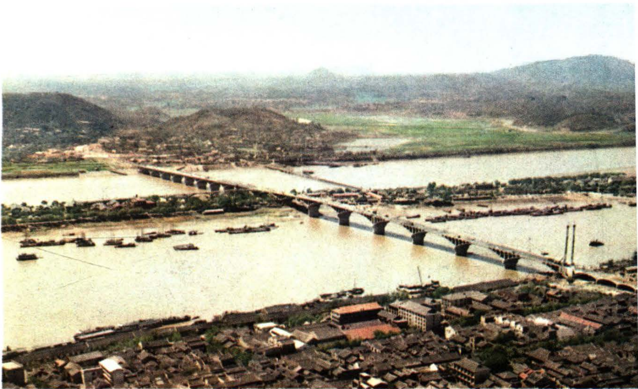
⑱ 湘江大桥
