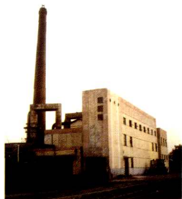
机务段供热车间
