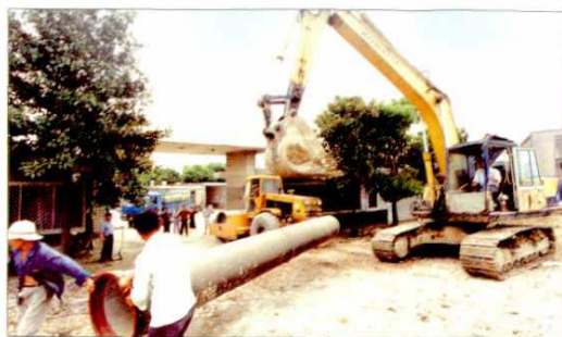
水厂接管通水现场
