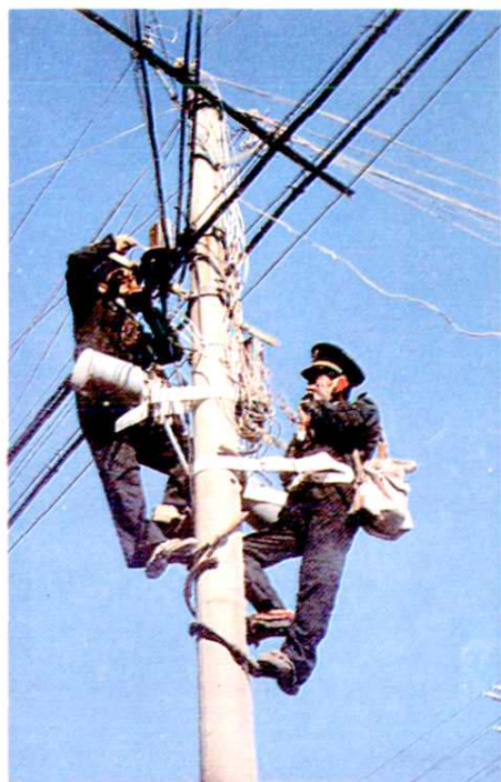
机线员杆上作业
