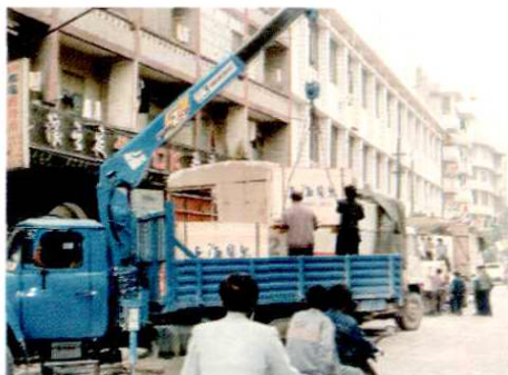
干部、职工踊跃参加装卸刚从上海运回的程控电话交换机设备(1992年10月)
