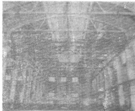
▲西安某厂钢筋砼预制装配结构厂房
