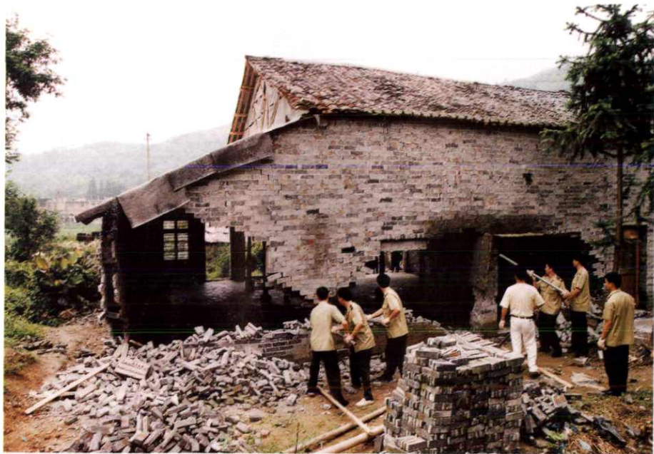
拆除违章建房
