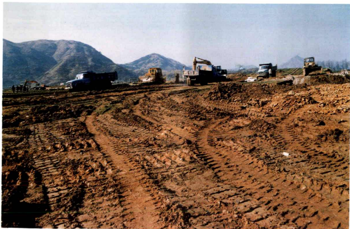
施工现场一角
