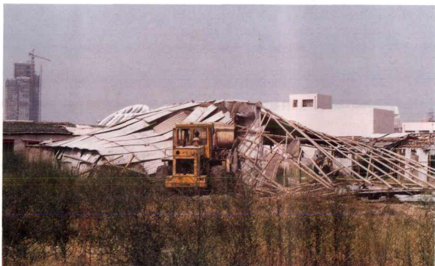
拆除违章棚屋
