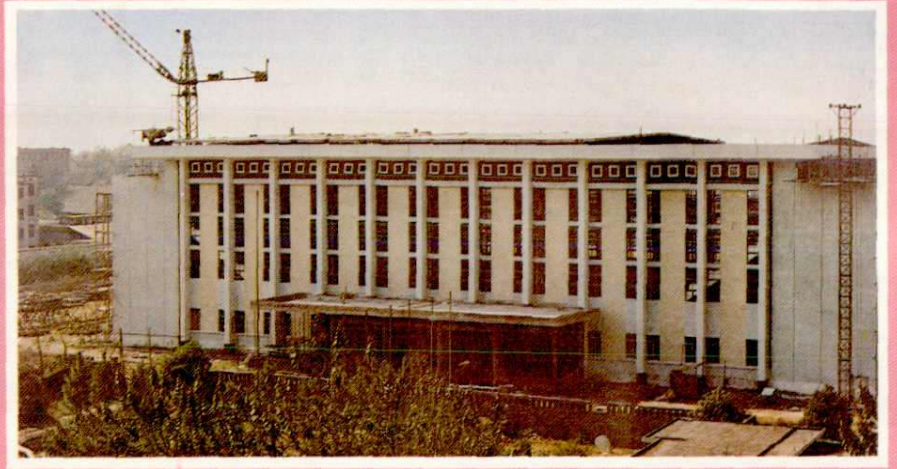
即将竣工的体育馆
