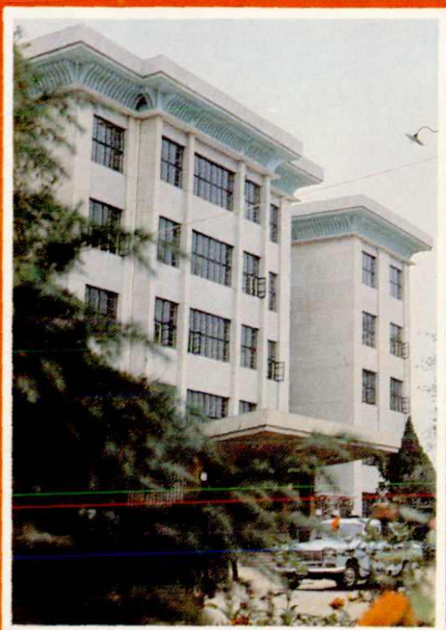
抚州地委机关办公大楼
