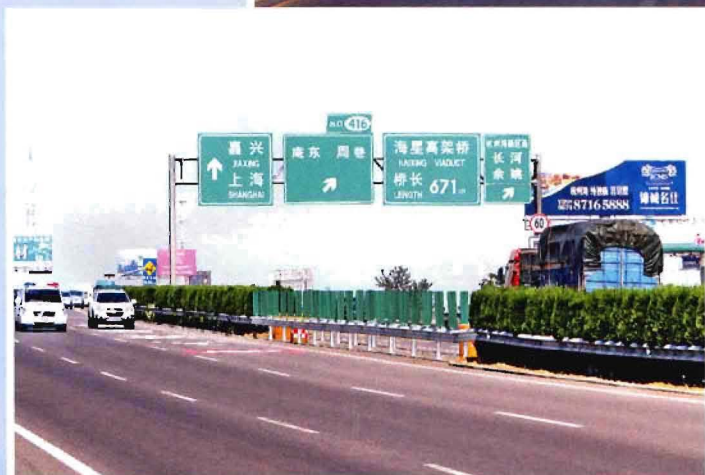
■ 沈海高速海盐高架桥
