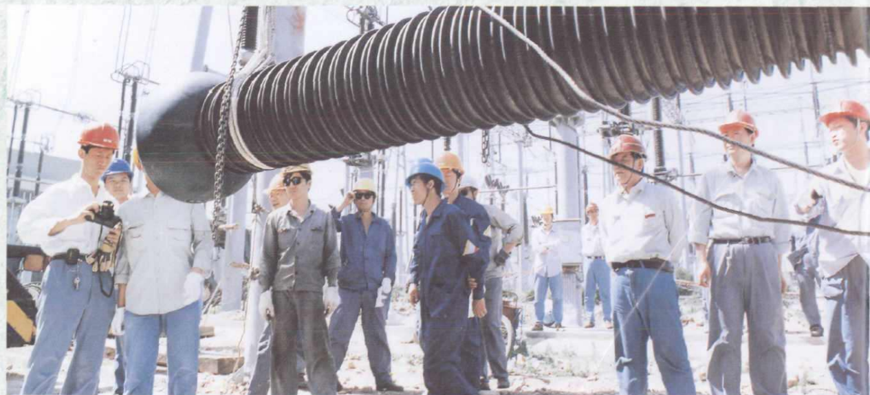
检修 500 千伏升压站
