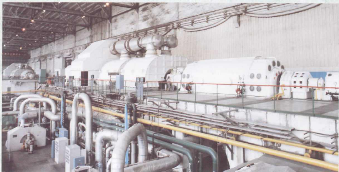
1975、1980年投产的1、2号30万千瓦汽轮发电机组
