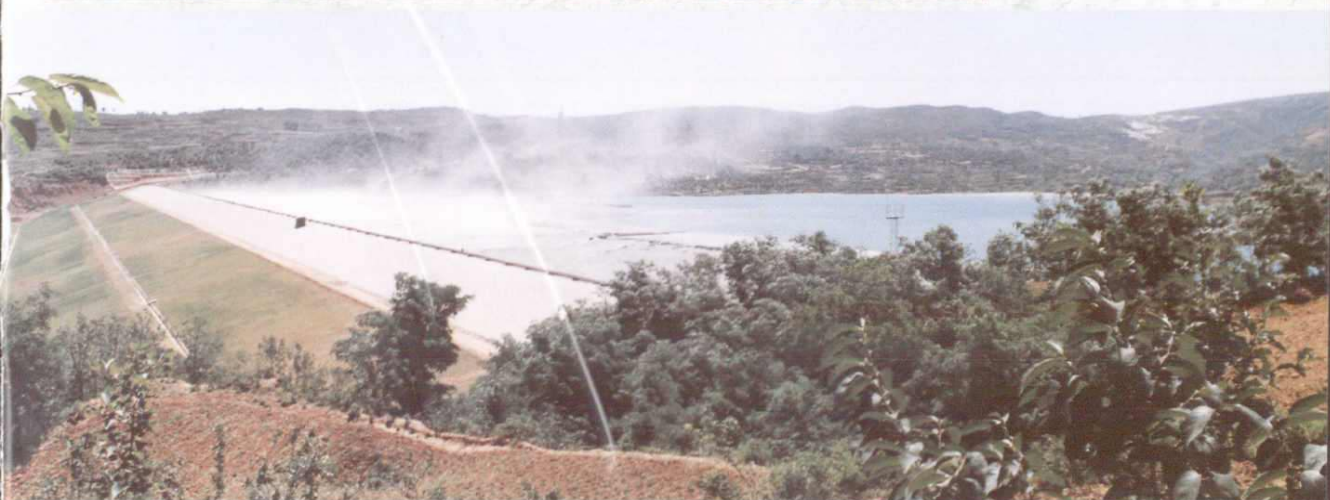
1988年11月建成的库容1.4亿米 3 的程寨沟贮灰场
