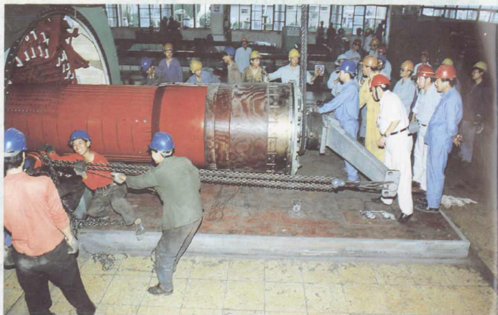
检修 30 万千瓦发电机
