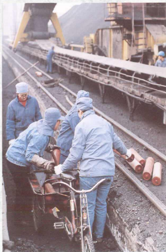
检修输煤皮带
