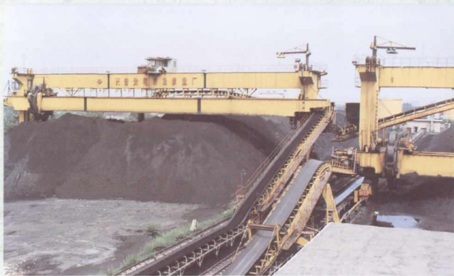
3、4号机组贮煤场
