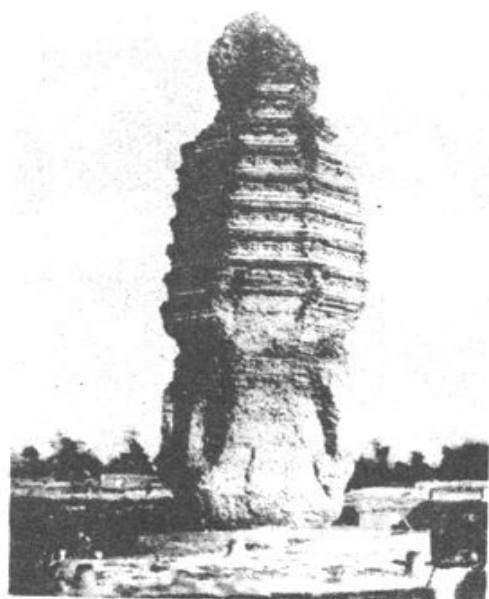
1953年维修前的辽塔
