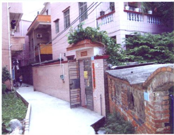
石溪东村街村民新楼房 (2007年5月摄)
