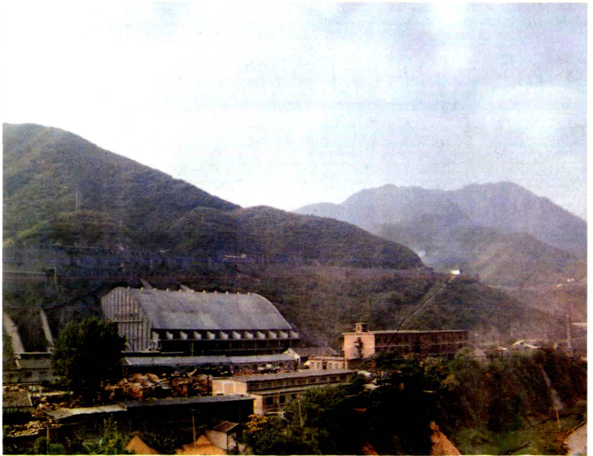
木城涧煤矿加盖煤仓
