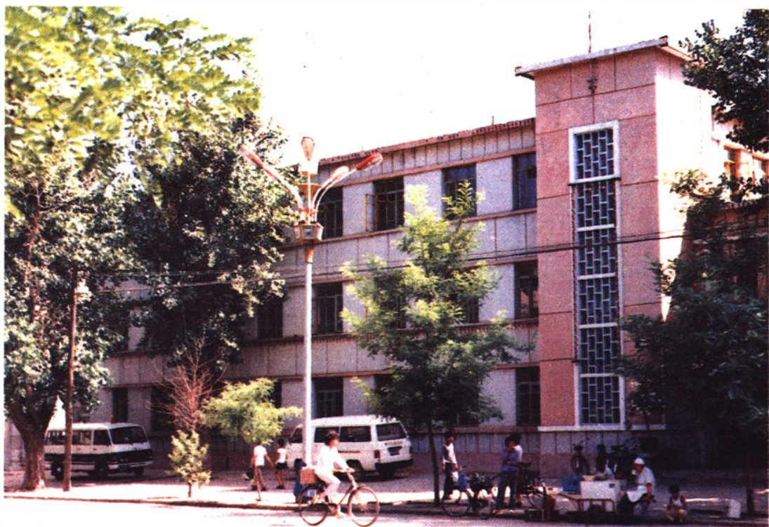
财政、建设银行合建办公楼 (1974. 4 ~ 1982. 9)
