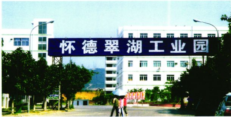
正在建设中的怀德翠湖工业园一貌
