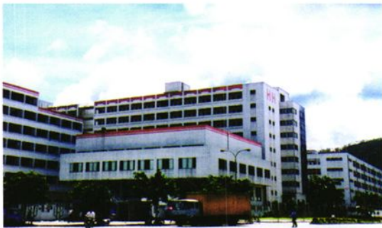
座落在怀德翠岗工业区的大企业鸿兴厂
