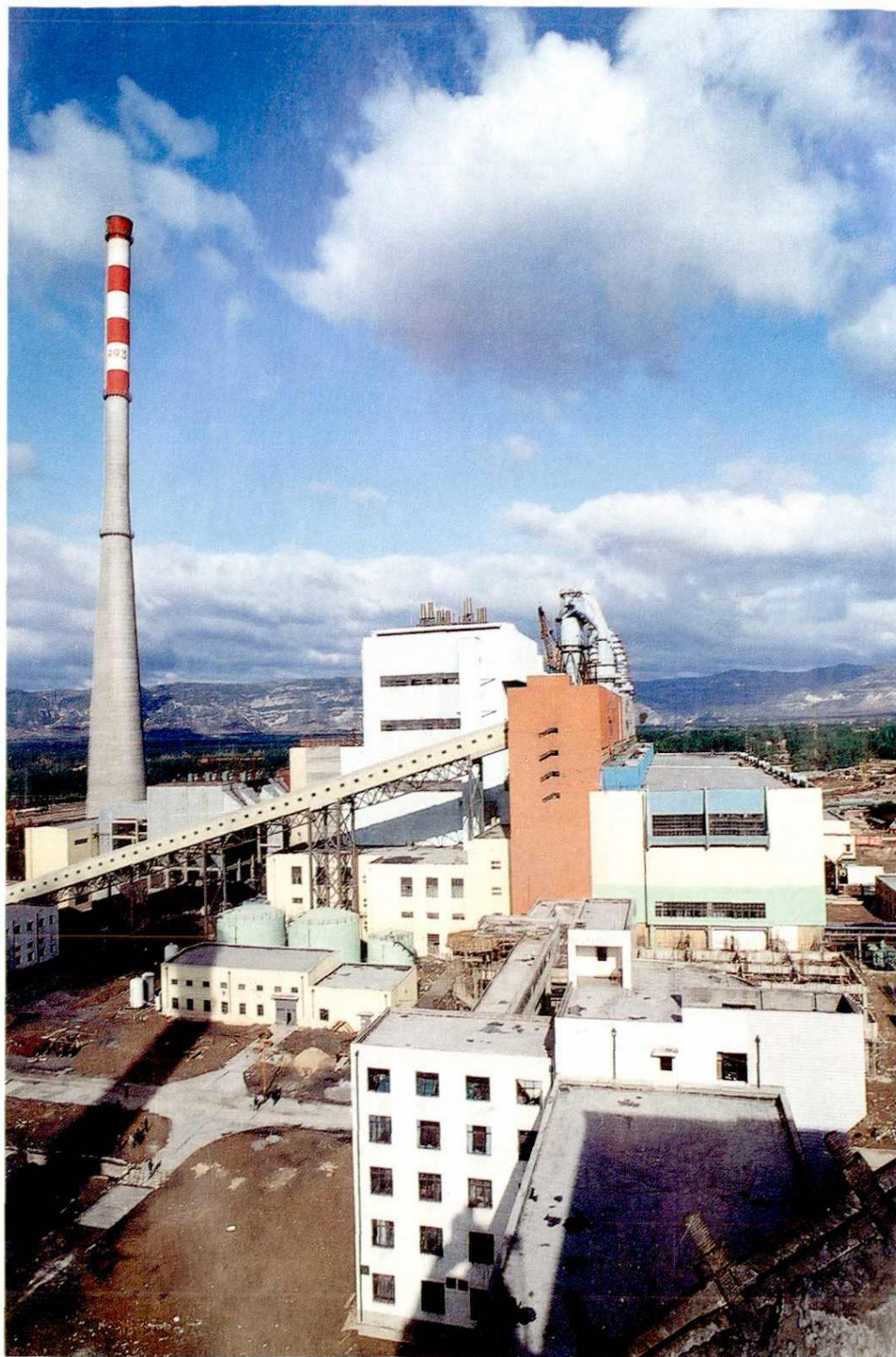
电建三公司承建的太原第二热电厂厂景
