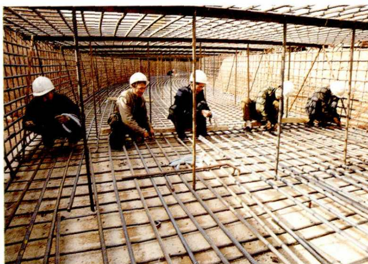
阳城电厂1号烟囱基础施工
