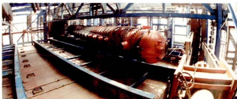
阳泉第二发电厂汽包吊装
