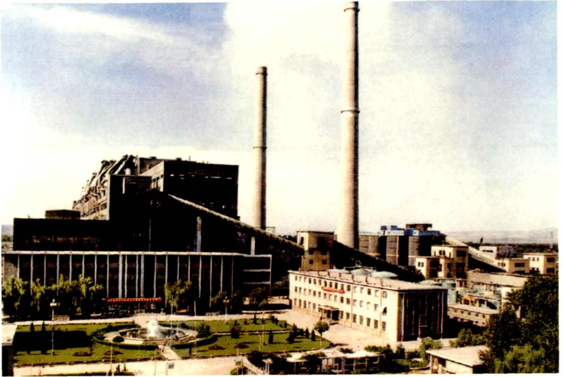
电建三公司承建的漳泽发电厂
