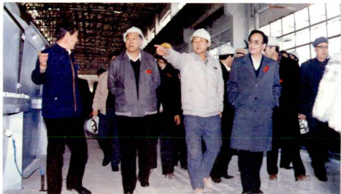
1989年12月，山西省省长王森浩(左四)、副省长吴俊洲(左二)到漳泽电厂现场了解施工情况
