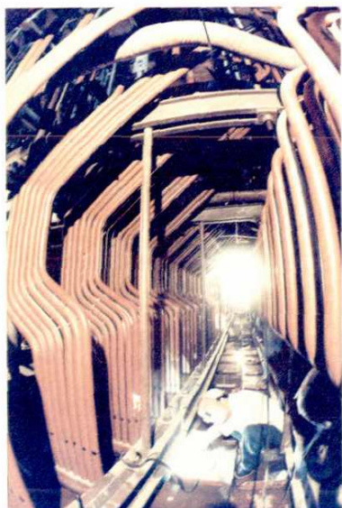
阳城电厂锅炉安装
