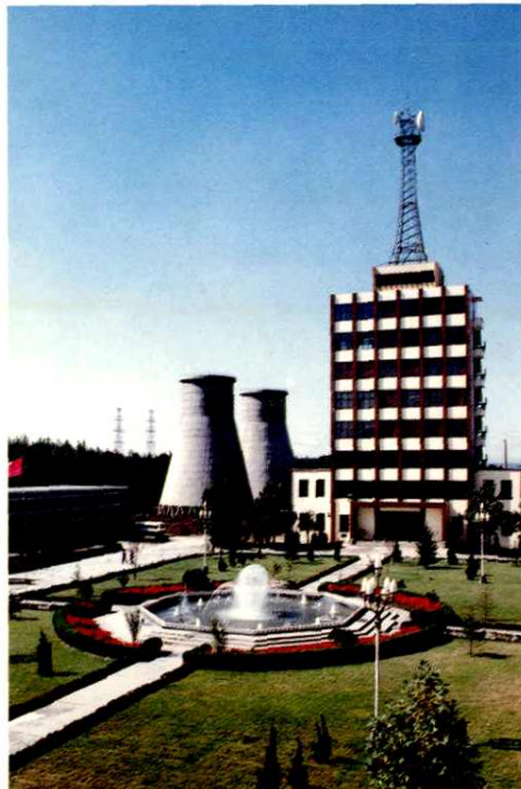
公司设计施工的漳泽电厂通讯大楼
