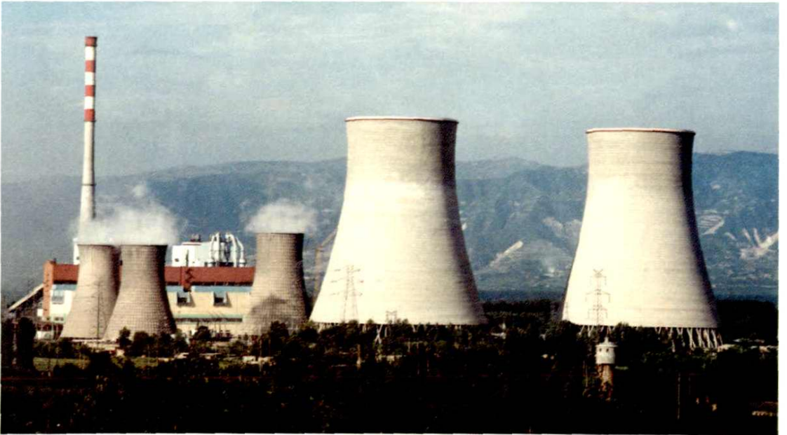
电建三公司承建的亚洲地区最大的双曲线空冷却塔(太原第二热电厂)
