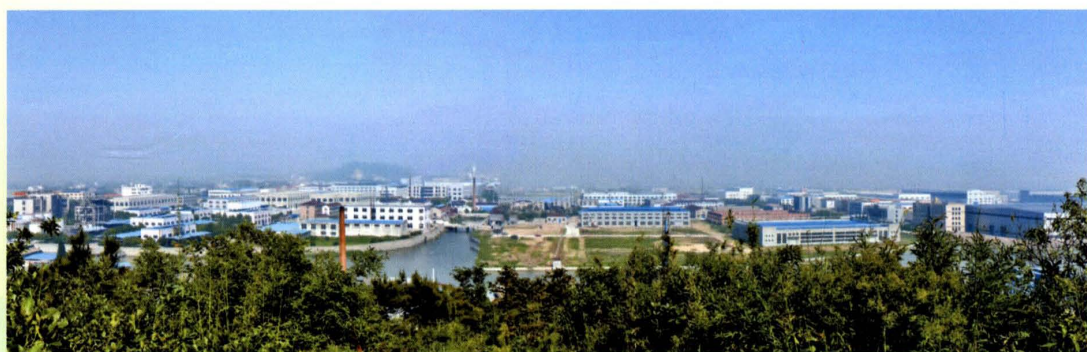
芳桥工业园区
