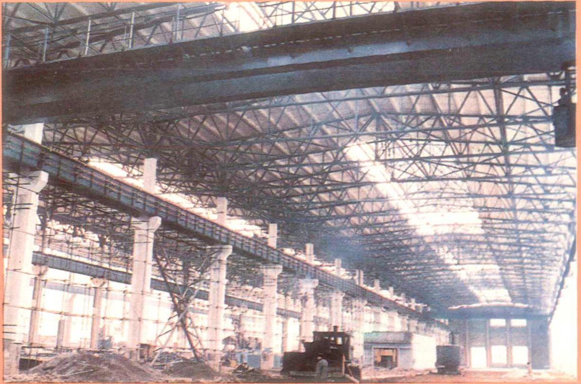
△东方锅炉厂“七五”计划技术改造重点项目之一的深井冲膜式水冷壁厂房
