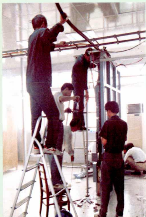
传输局完成合-屯微波干线马鞍山 站搬迁工程
