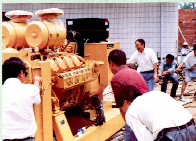
合肥卫星通信地球站施工现场
