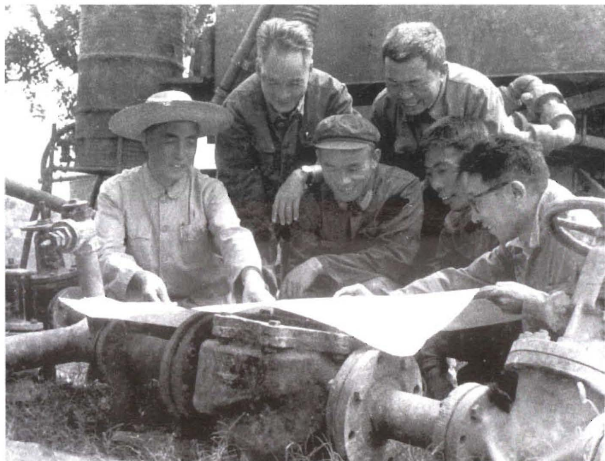
“三结合”水溶压裂法攻关小组在现场
