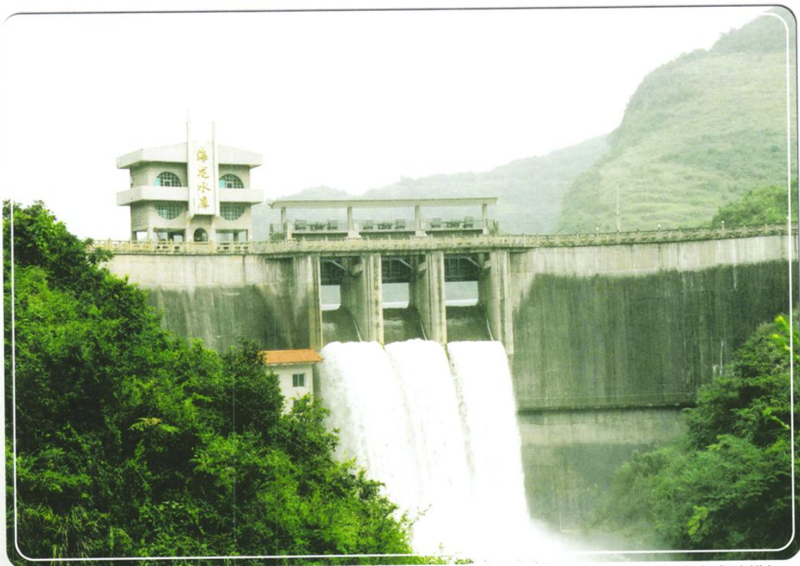
海龙水库砼拱坝
