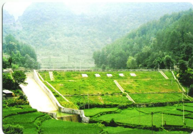
打洞垭水库大坝
