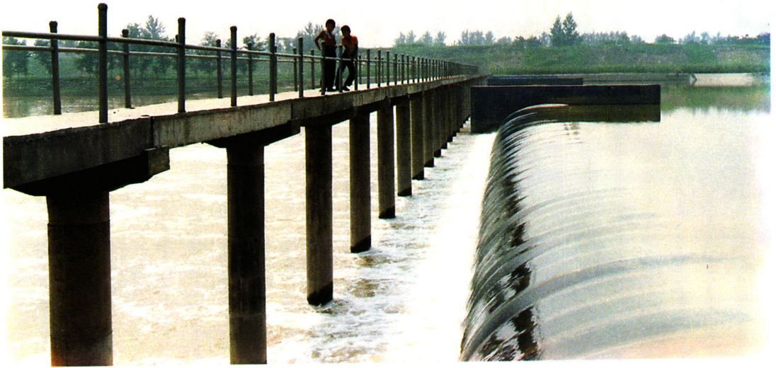
金乡县东鱼河曹庄橡胶坝
