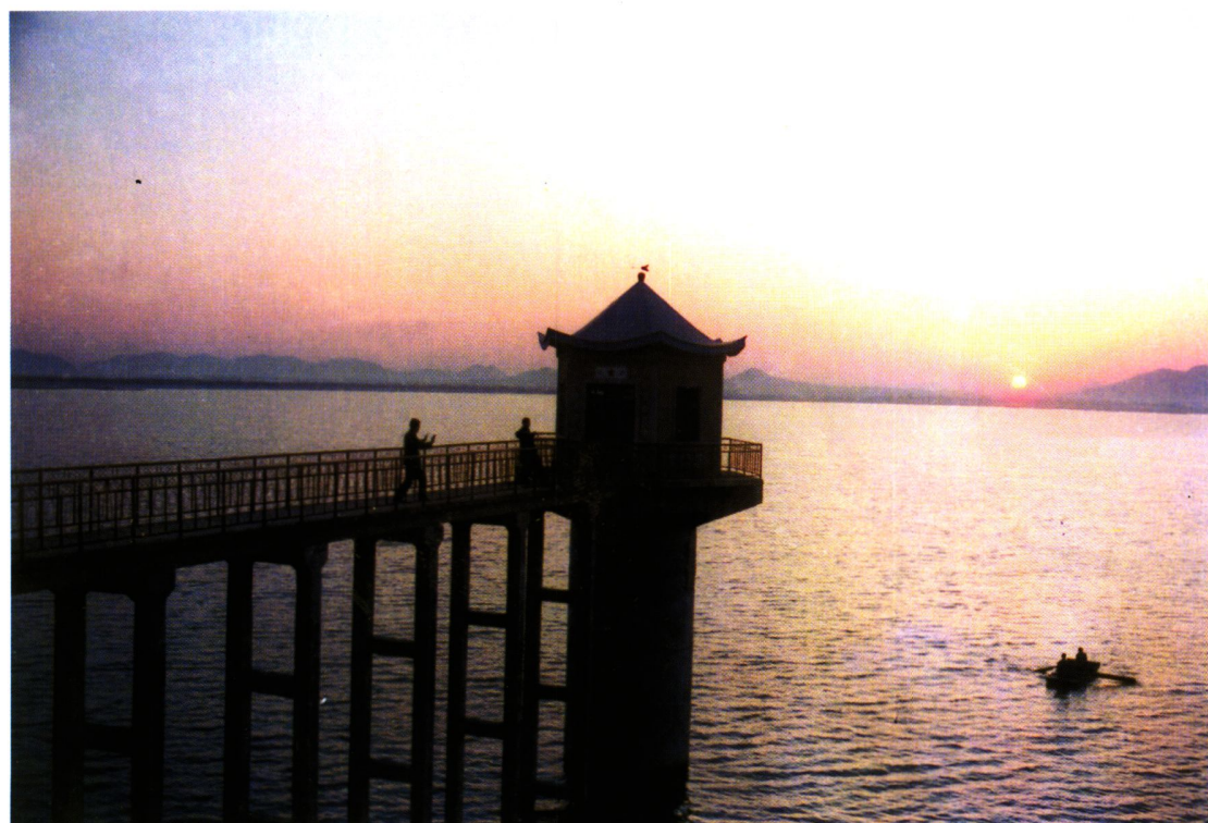
邹县西苇水库
