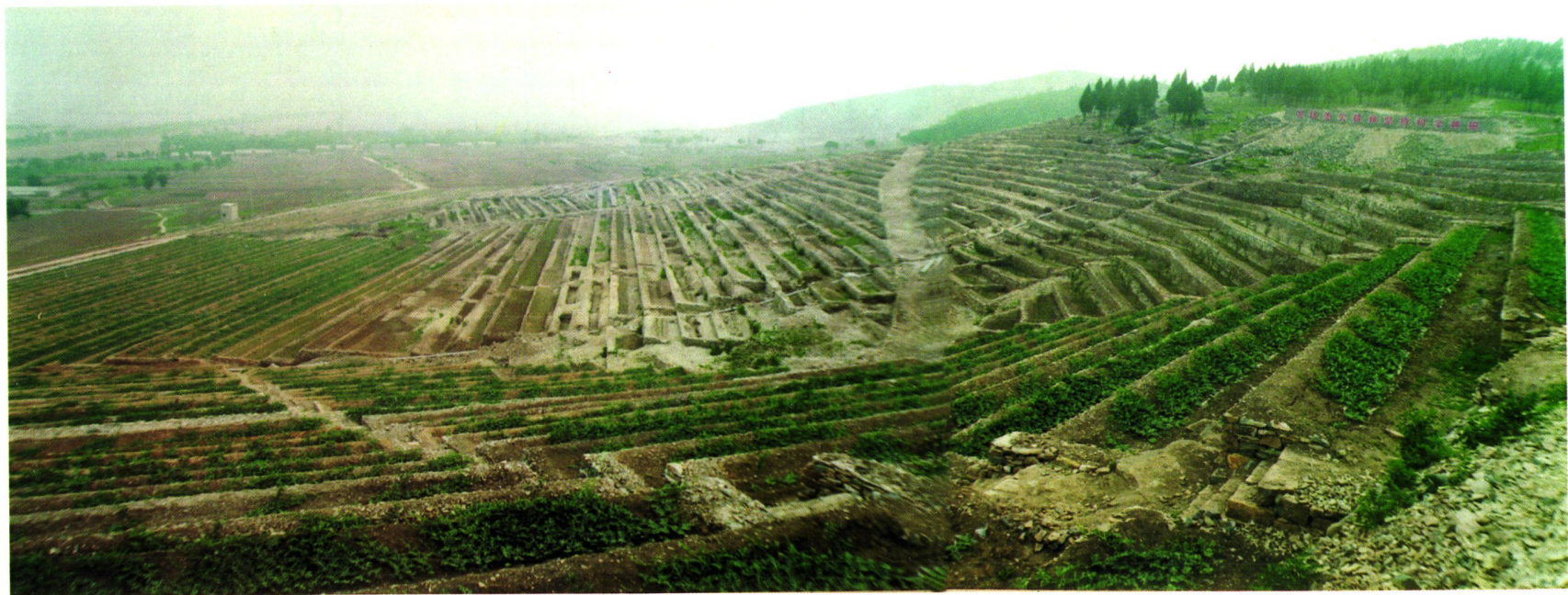
邹县东山头水土保持工程
