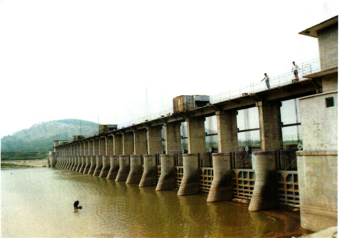
洙赵新河梁山节制闸
