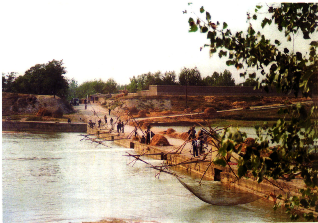
泗河兗州縣金口壩水利遺址
