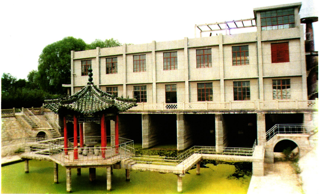
洙水河嘉祥抽水站
