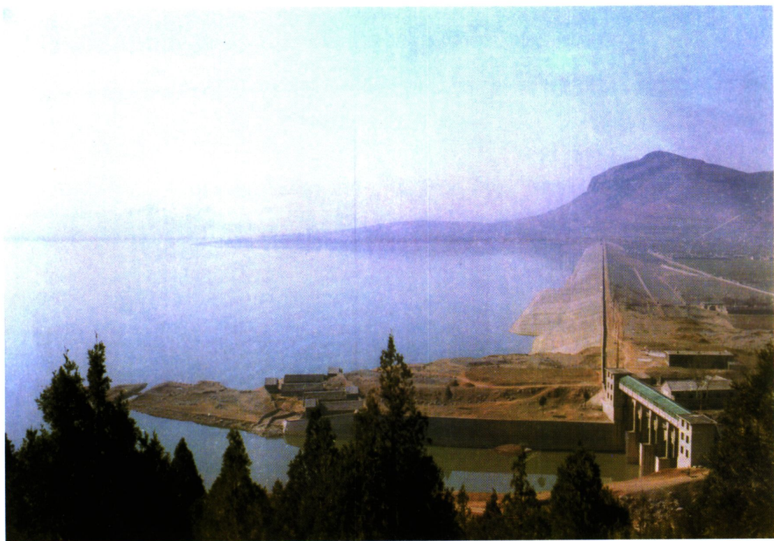
曲阜尼山水库全景
