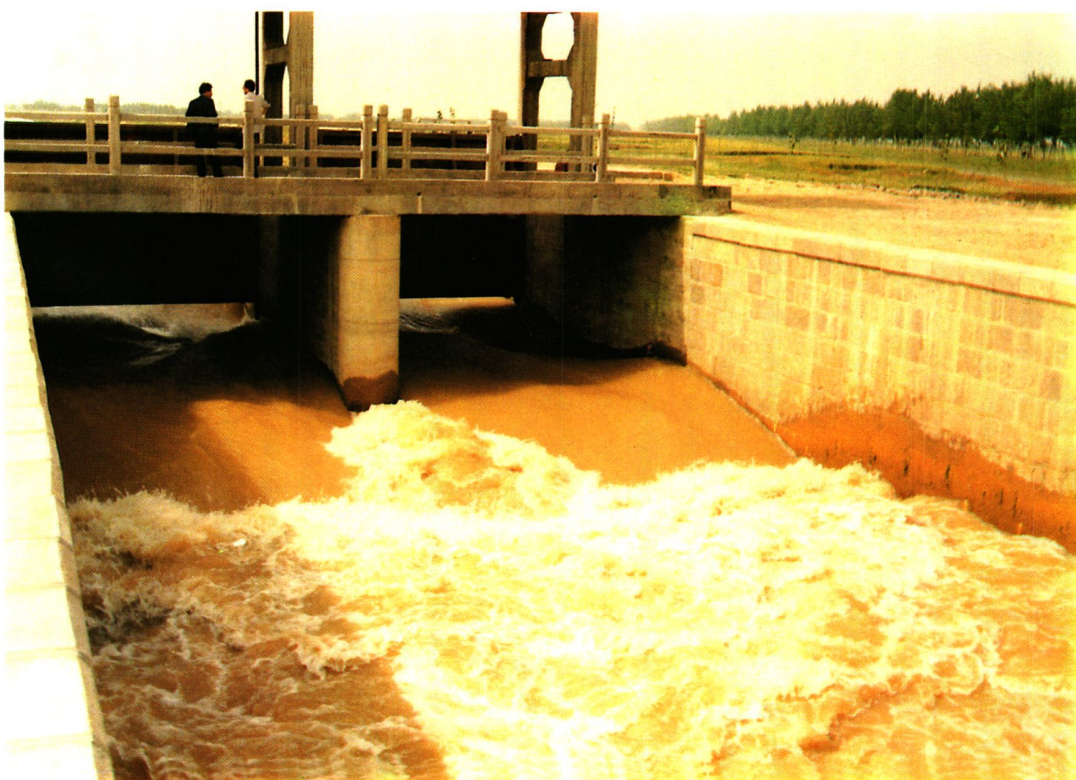
梁山县国那里引黄灌区码头闸
