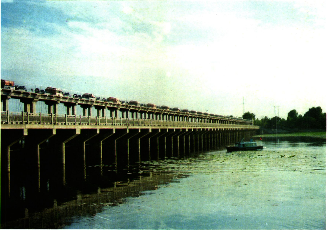
南四湖二级坝第二节制闸
