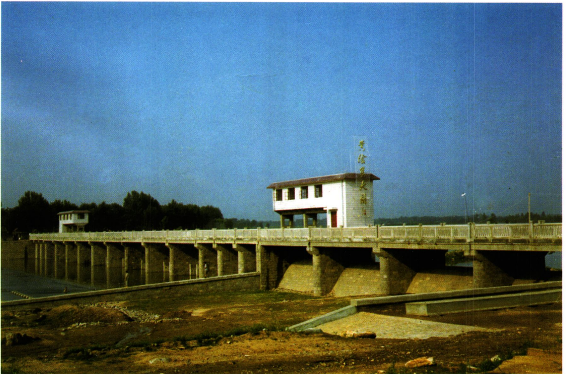
泗河泗水县黄阴集拦河闸
