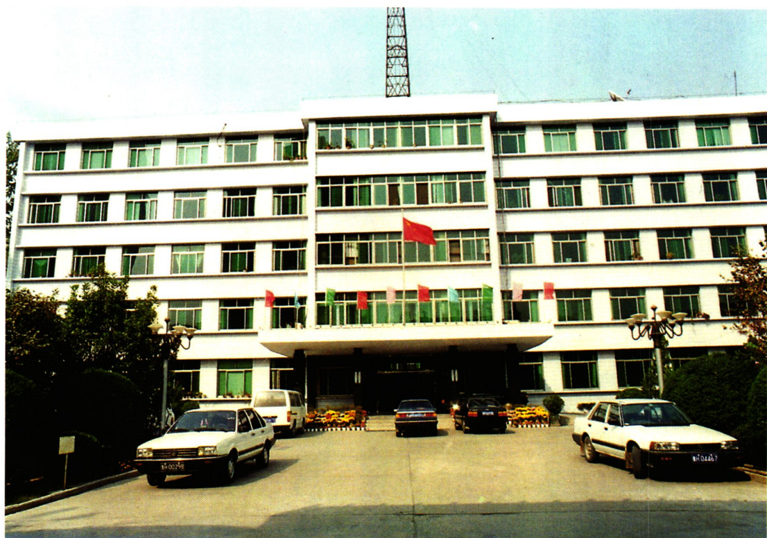
济宁市水利局办公楼
