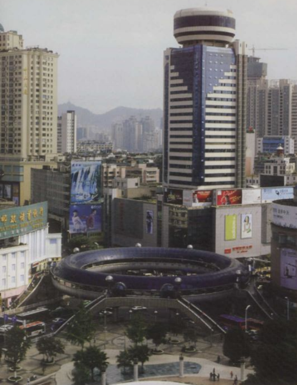
1997年通过招商引资修建的贵阳市大十字环形人行天桥
