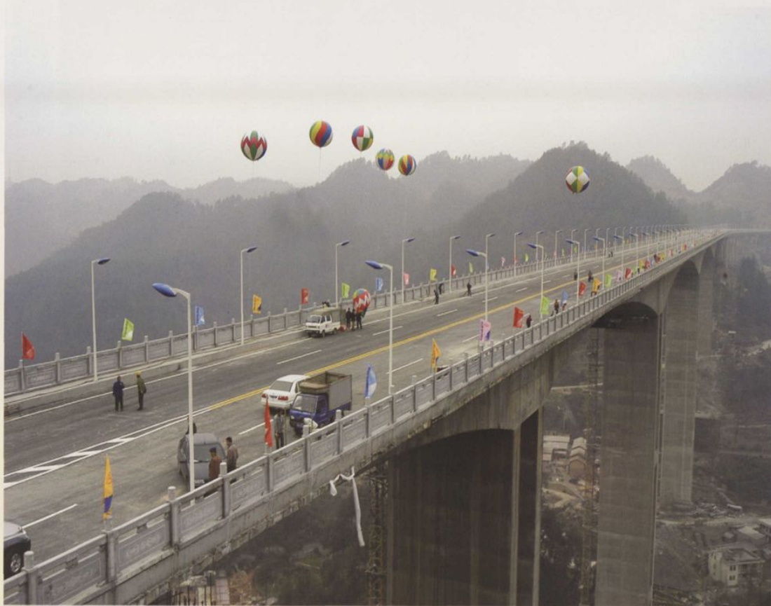
2003年竣工的小关特大桥,是贵阳连接金阳新区的重要桥梁,主桥跨度为16米,其中3号墩高度为100米
