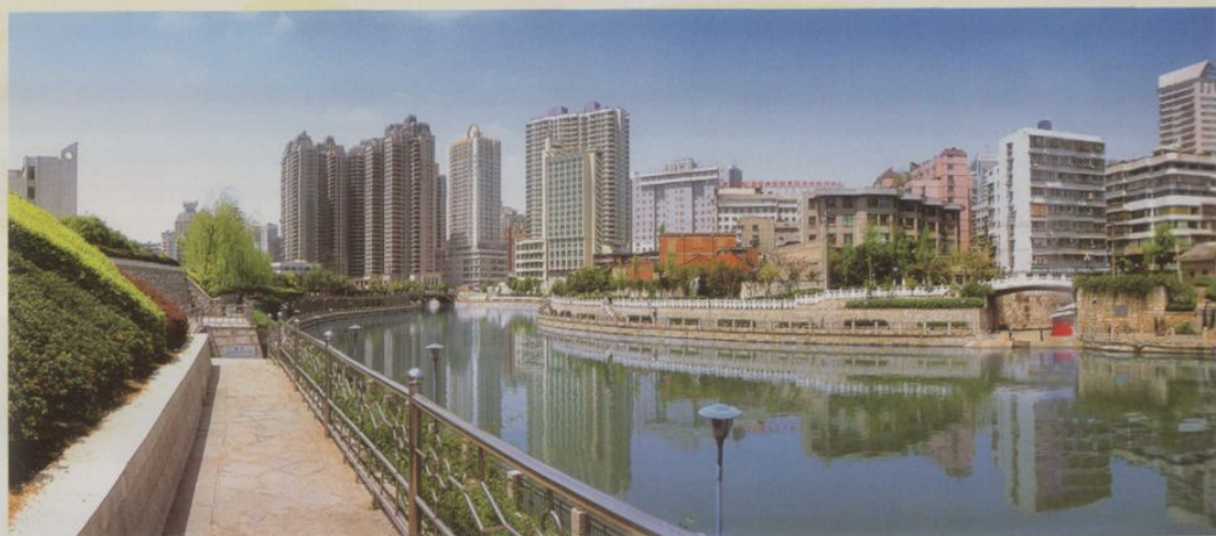
2004年,综合整治后的南明河贵阳一中河段
