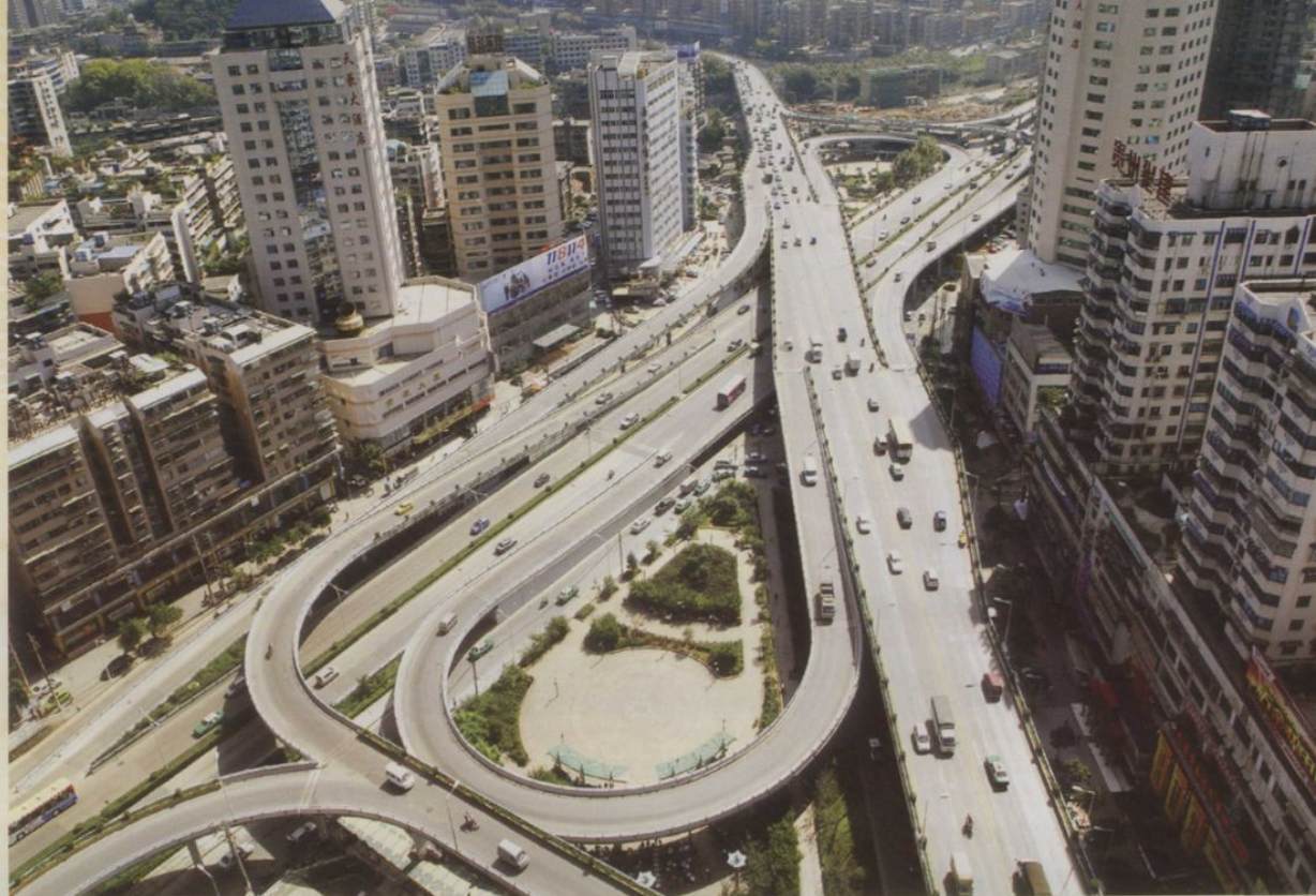
1993年竣工的贵阳市花果园三层互通式立交桥
