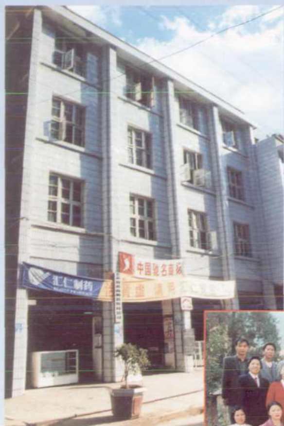
县医药公司办公楼
