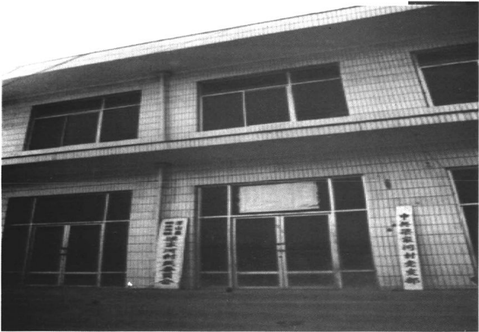
新建的村两委办公楼
