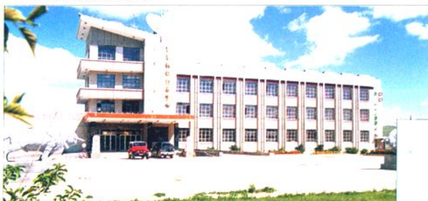
林业局办公楼
