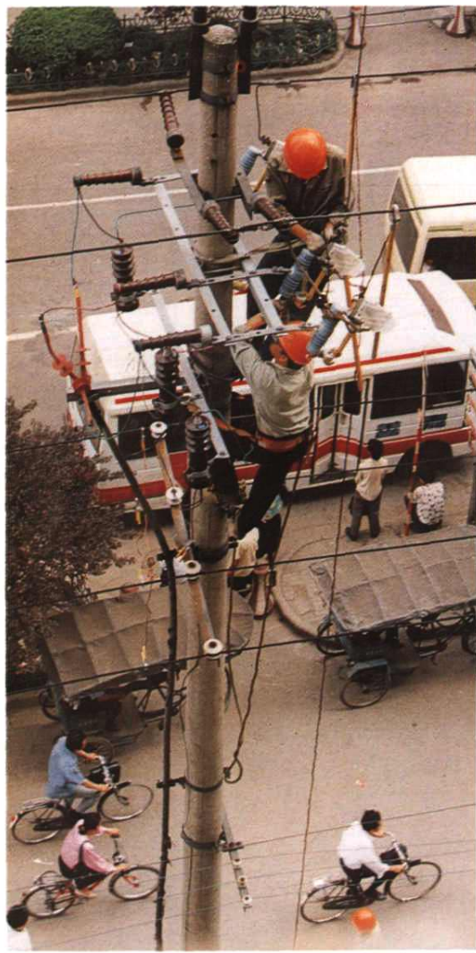
嘉兴市区中山路配电线路改造
