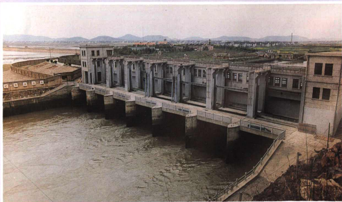
海盐县长山泄洪闸
