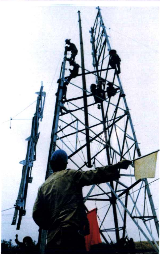
双山变电所220千伏线路开口工程架塔施工现场
