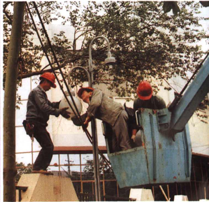
嘉兴市区路灯检修
