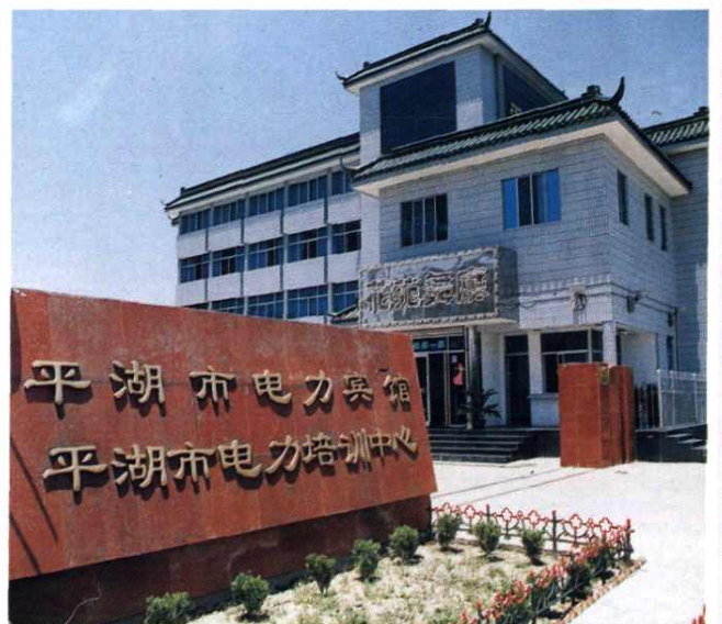
平湖市电力宾馆及电力培训中心
