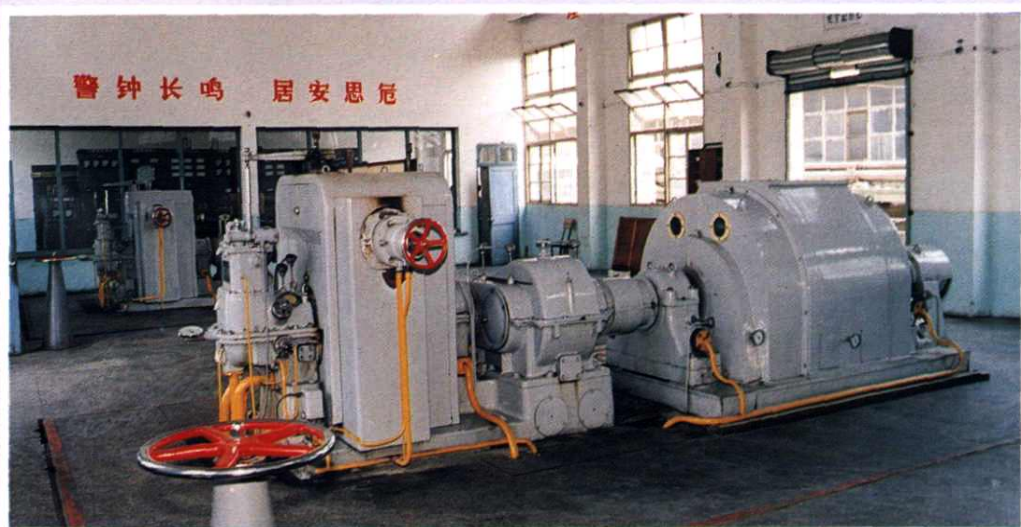
嘉兴纺织厂 1500 千瓦背压式汽轮发电机组
