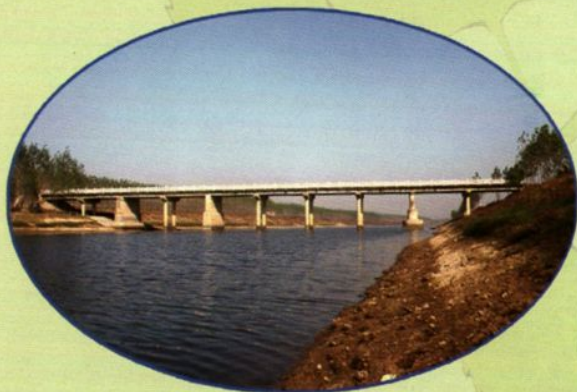
1983年5月竣工的新濉河大桥
