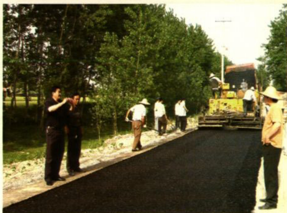
“通达工程”施工现场
