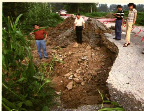
县交通局局长姜德光（左一） 副局长李强（左二）现场指挥水毁路段抢修
