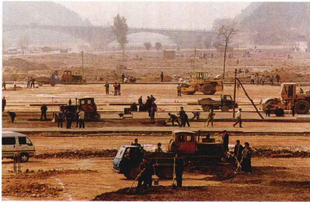
龙门石窟环境治理施工现场
