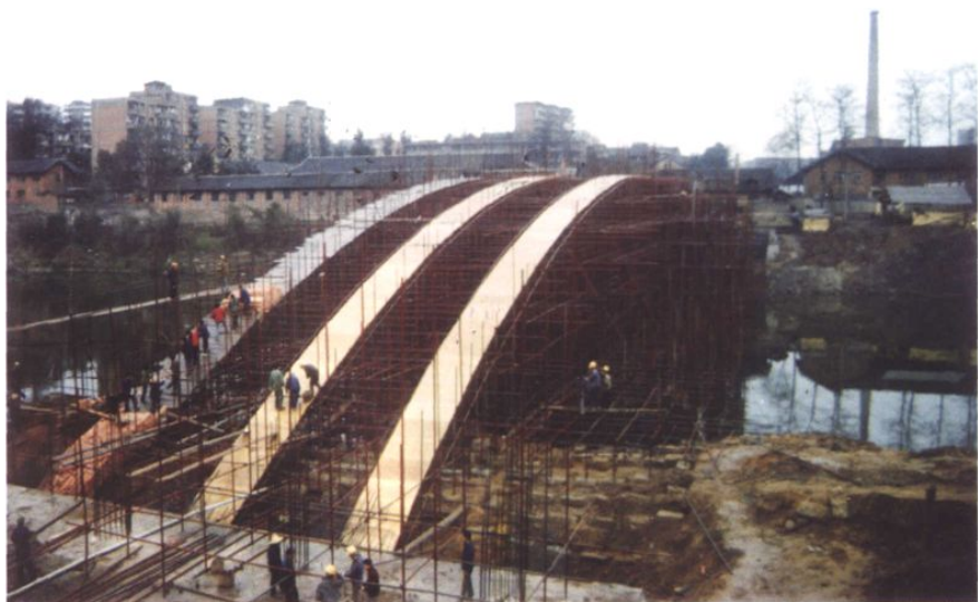
东兴寺釜溪河大桥建设工地1993—1994
