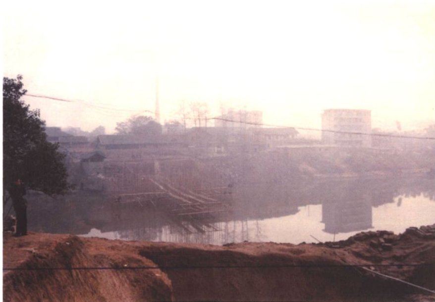
东兴寺釜溪河大桥现场
