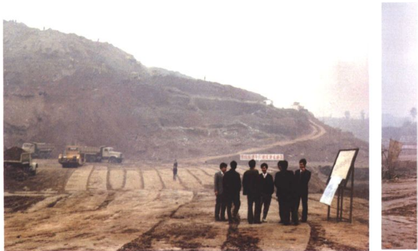
丹桂大街建设工地
