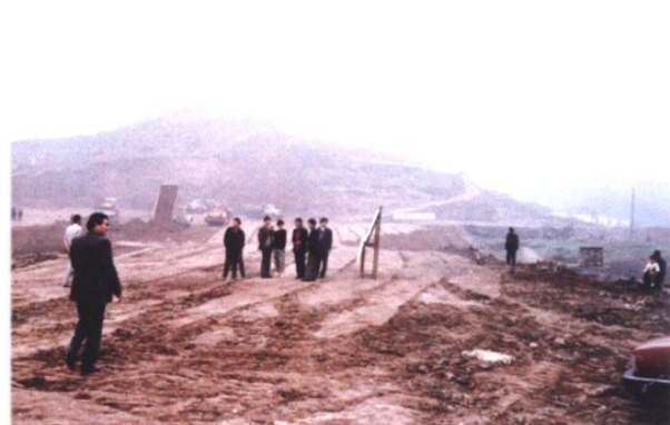
丹桂大街建设工地
