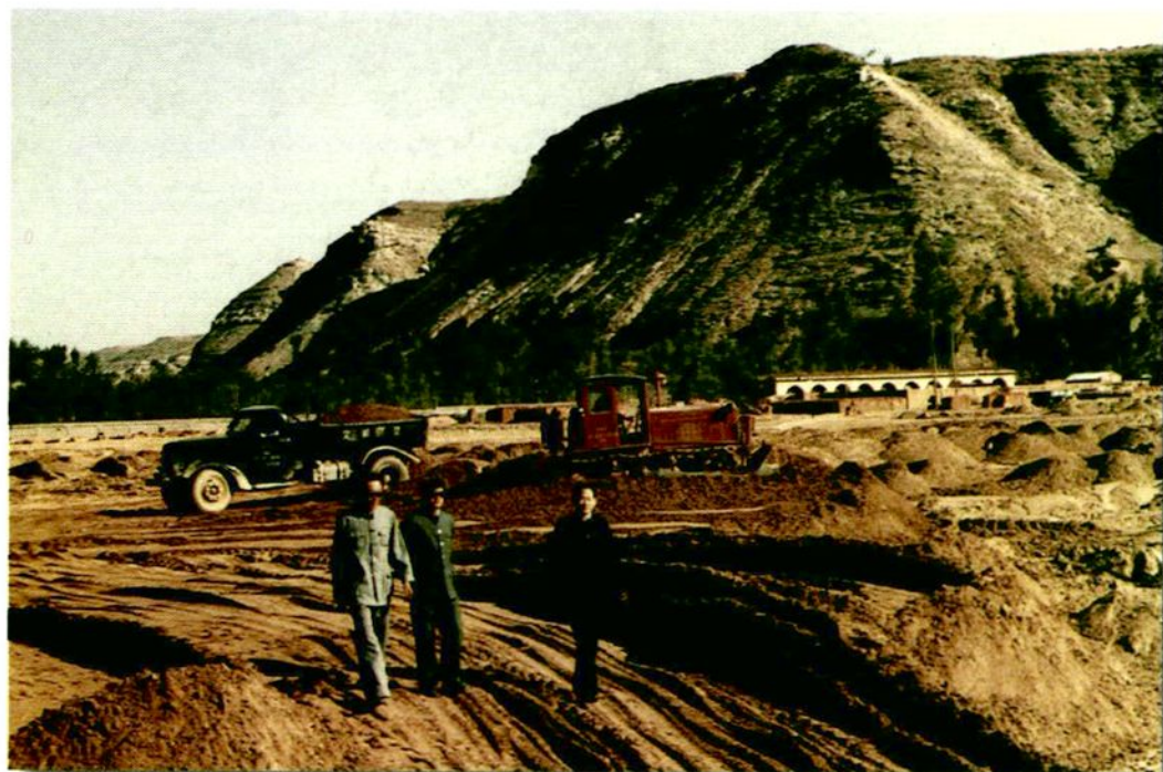
一期电厂开工建设现场
