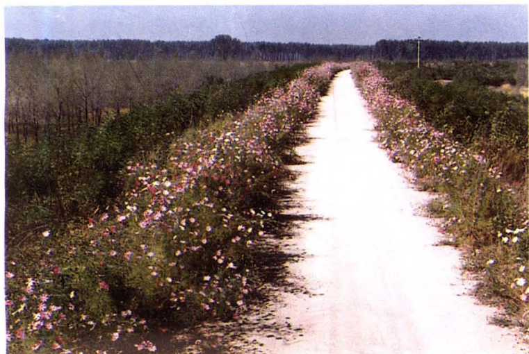
辽河“五化”堤防建设(开原段)
