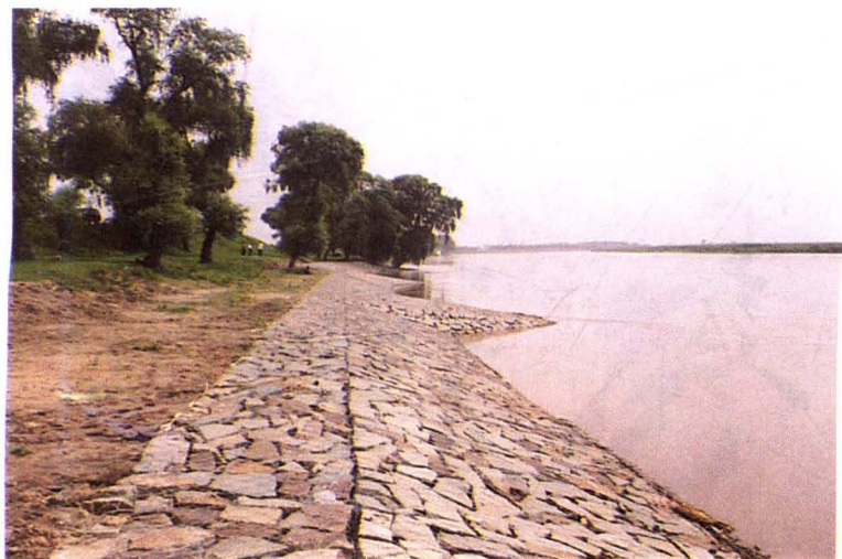
辽河削坡护岸工程(顾官屯险工)
