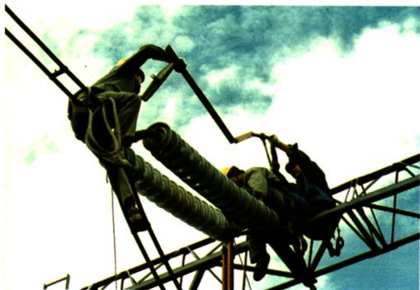
18 精心维修输电线路
