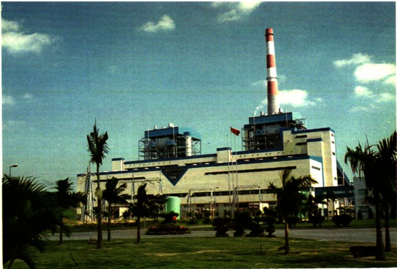
9 厦门嵩屿电厂外景
