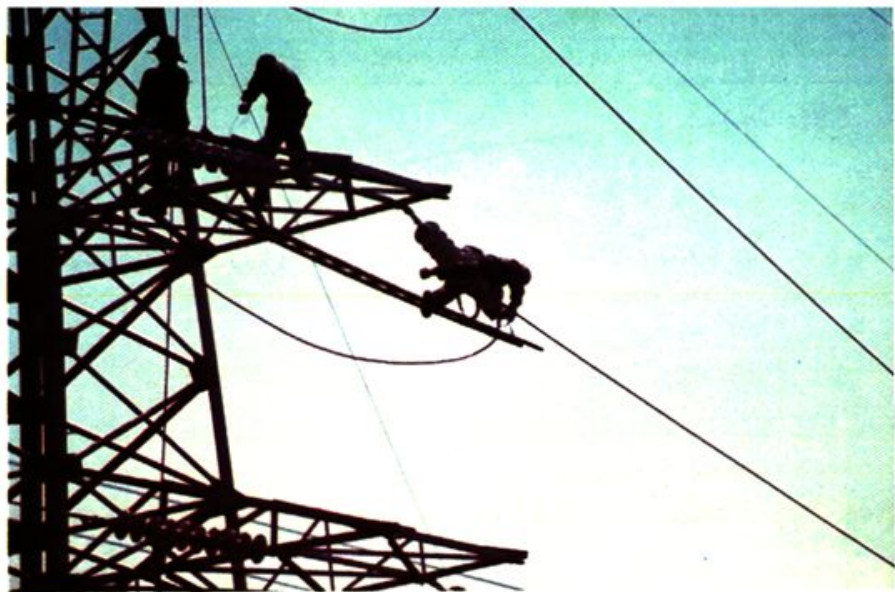
14 220千伏李东线 在施工中
