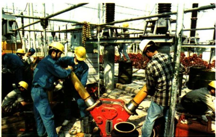
19 认真维修 变电站
