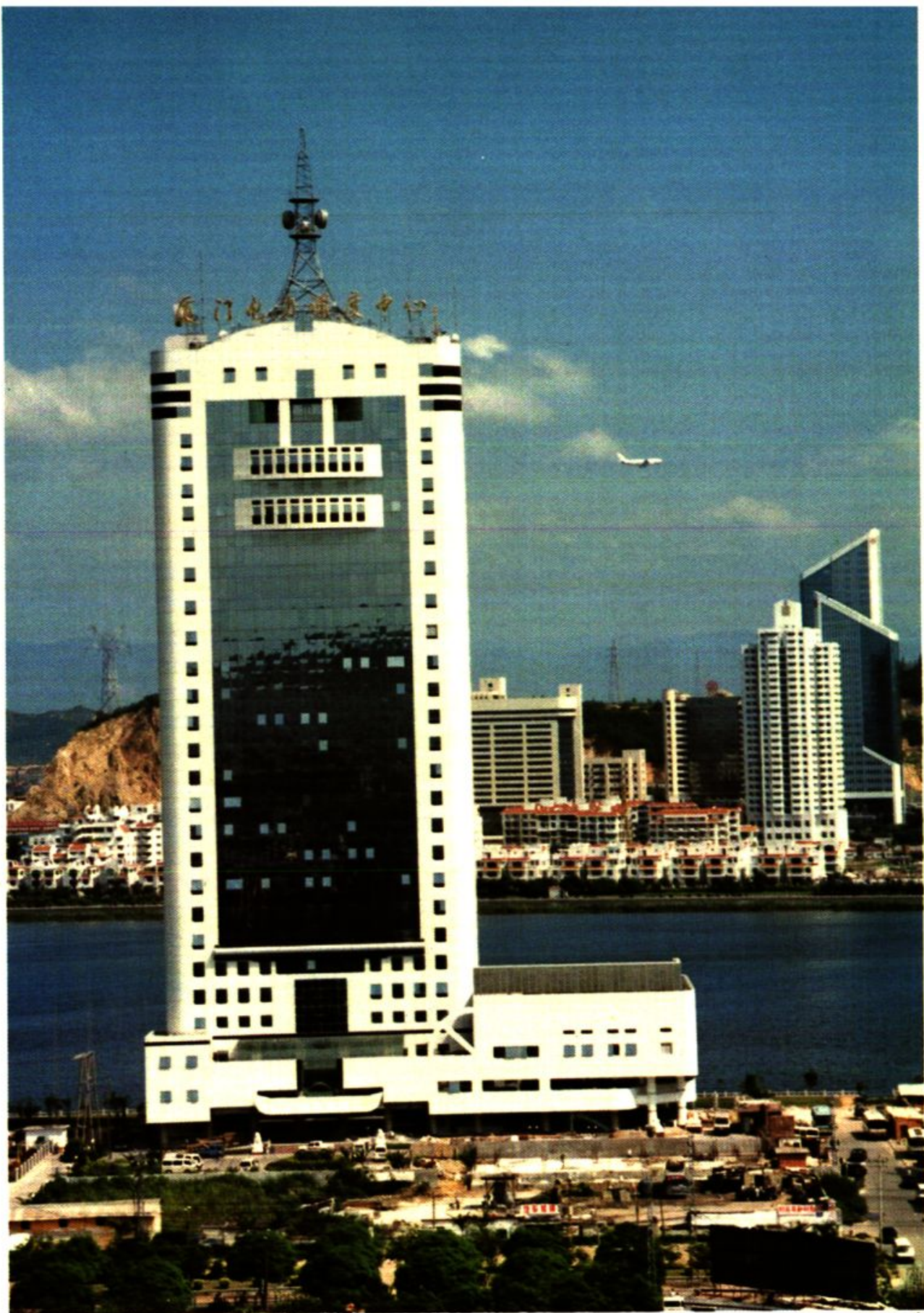
6 厦门电力调度中心
