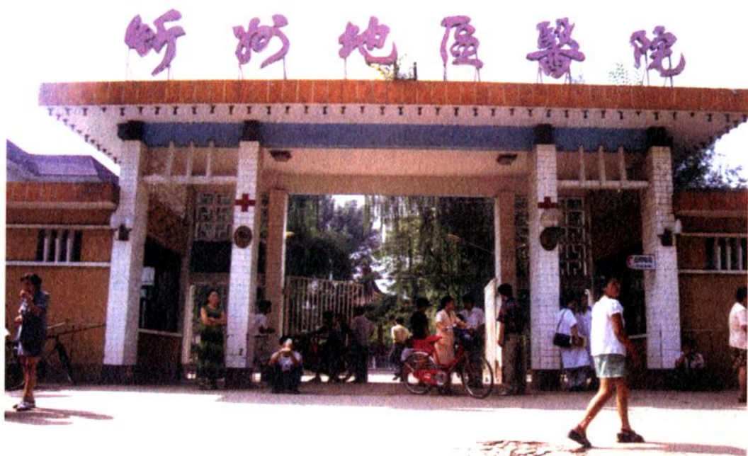
忻州地区医院住院部
