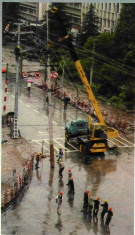
冒雨抢修故障电力线路
