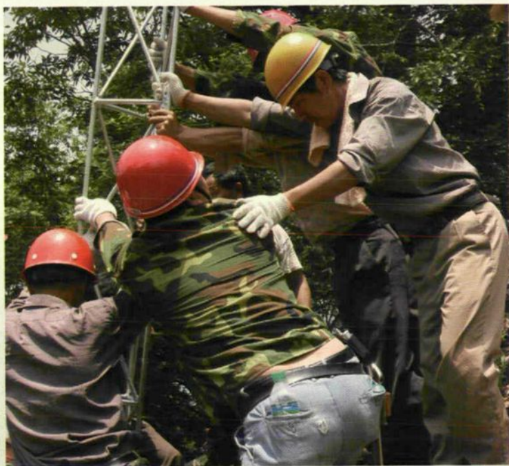
“户户通电”工程施工
