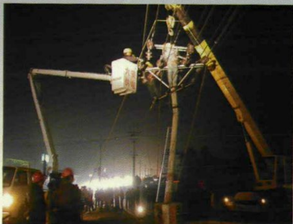
连夜抢修遭外破的电力线路
