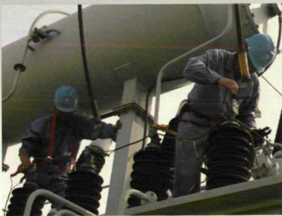
变电站断路器检修
