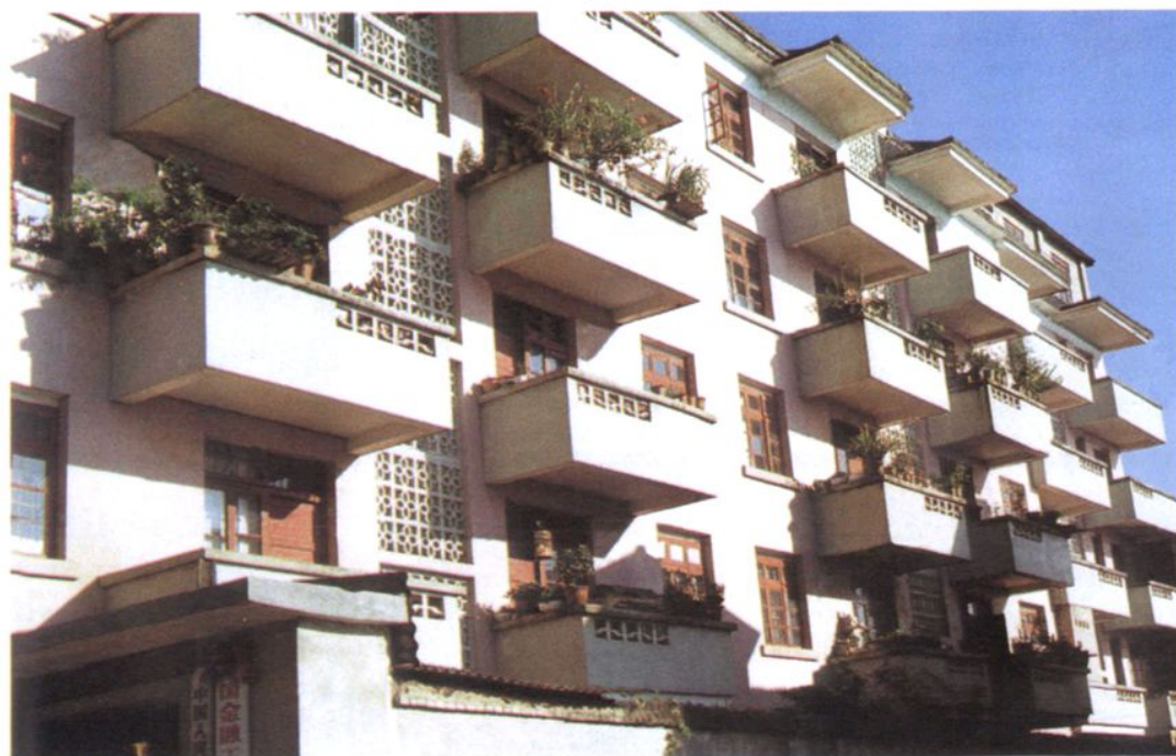
元阳县城新街的办公大楼
