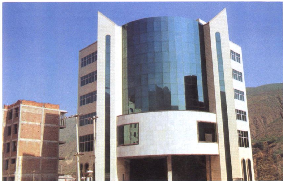
兴建中的南沙新区办公大楼
