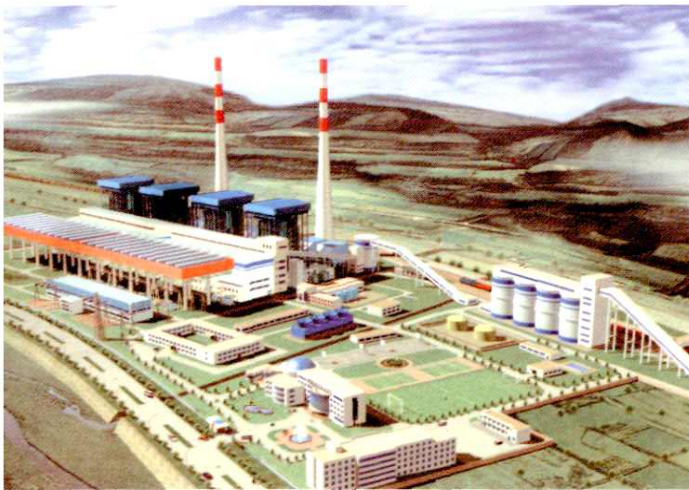
正在建设中的古交发电厂
