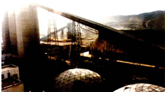
年入洗能力400万吨的燕子山洗煤厂
