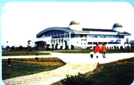
1997年10月1日建成启用的斗门体育馆
