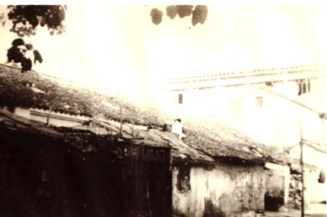
安定书院旧址
