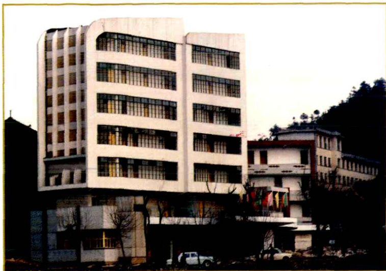
黔南州劳动就业培训 中心大楼
