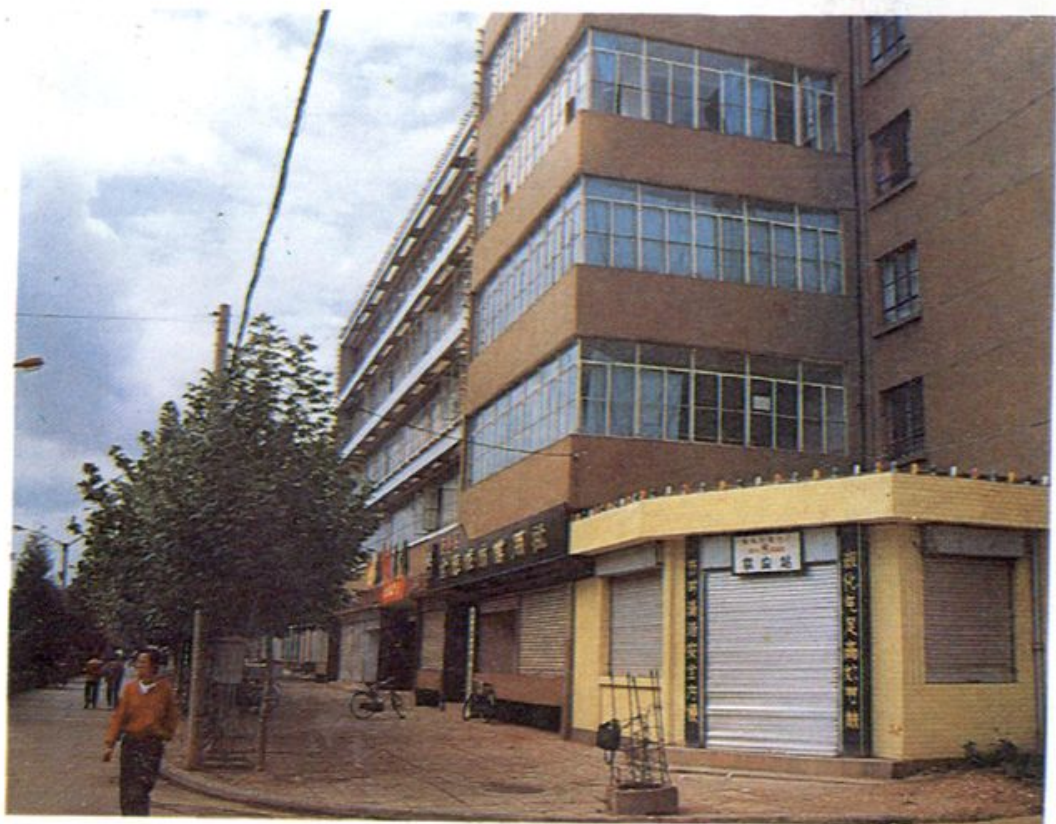
△ 禄丰县新建福利厂大楼
