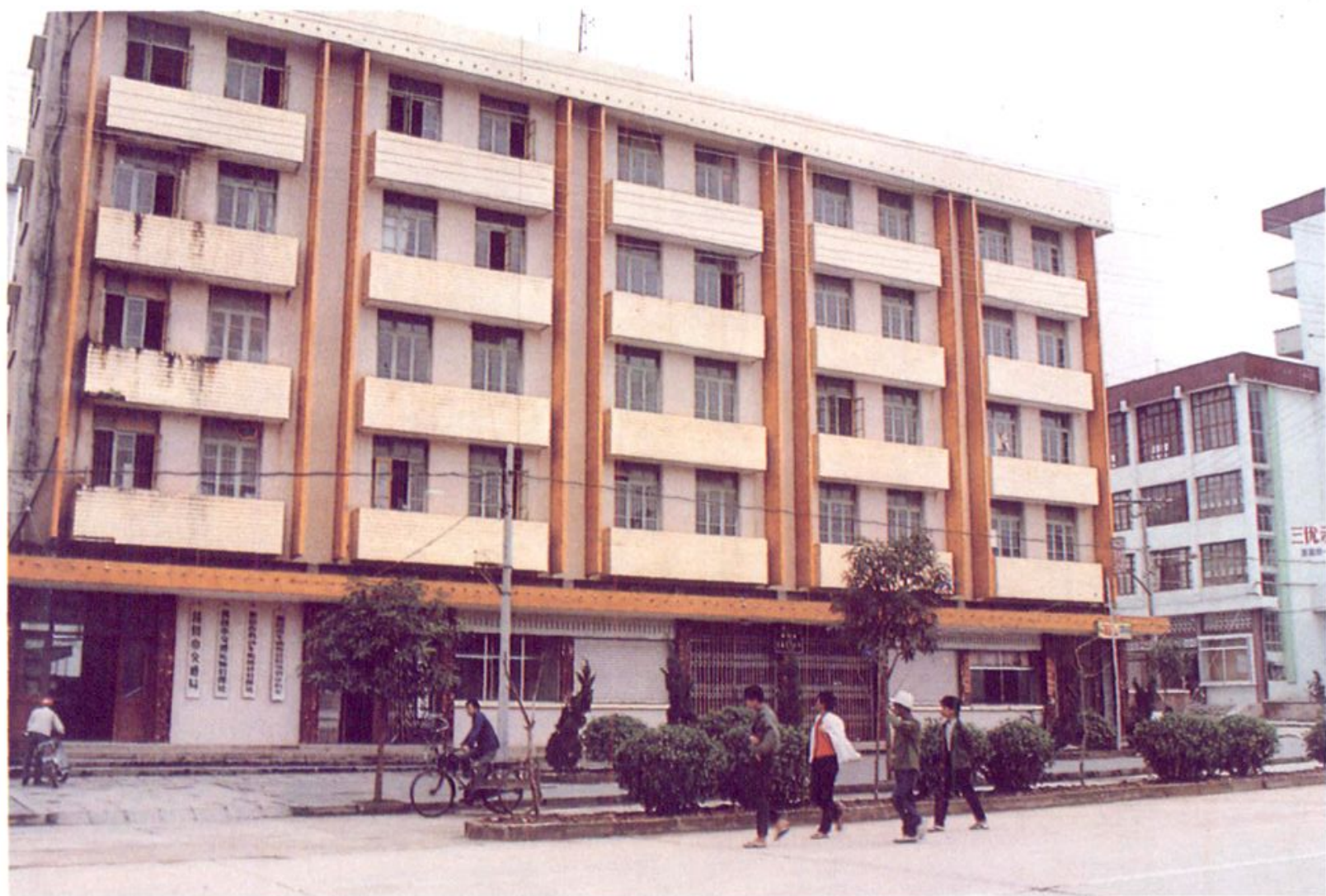
市交通局办公大楼
