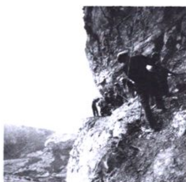
◀新华水沟修建现场
