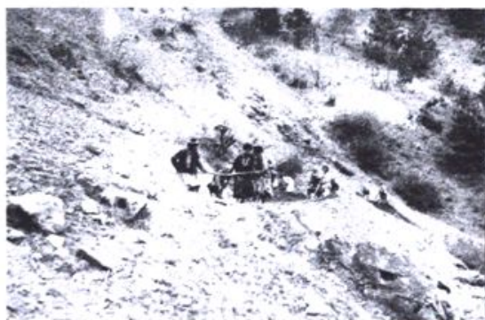
▲修建德庆水沟(1957年)
