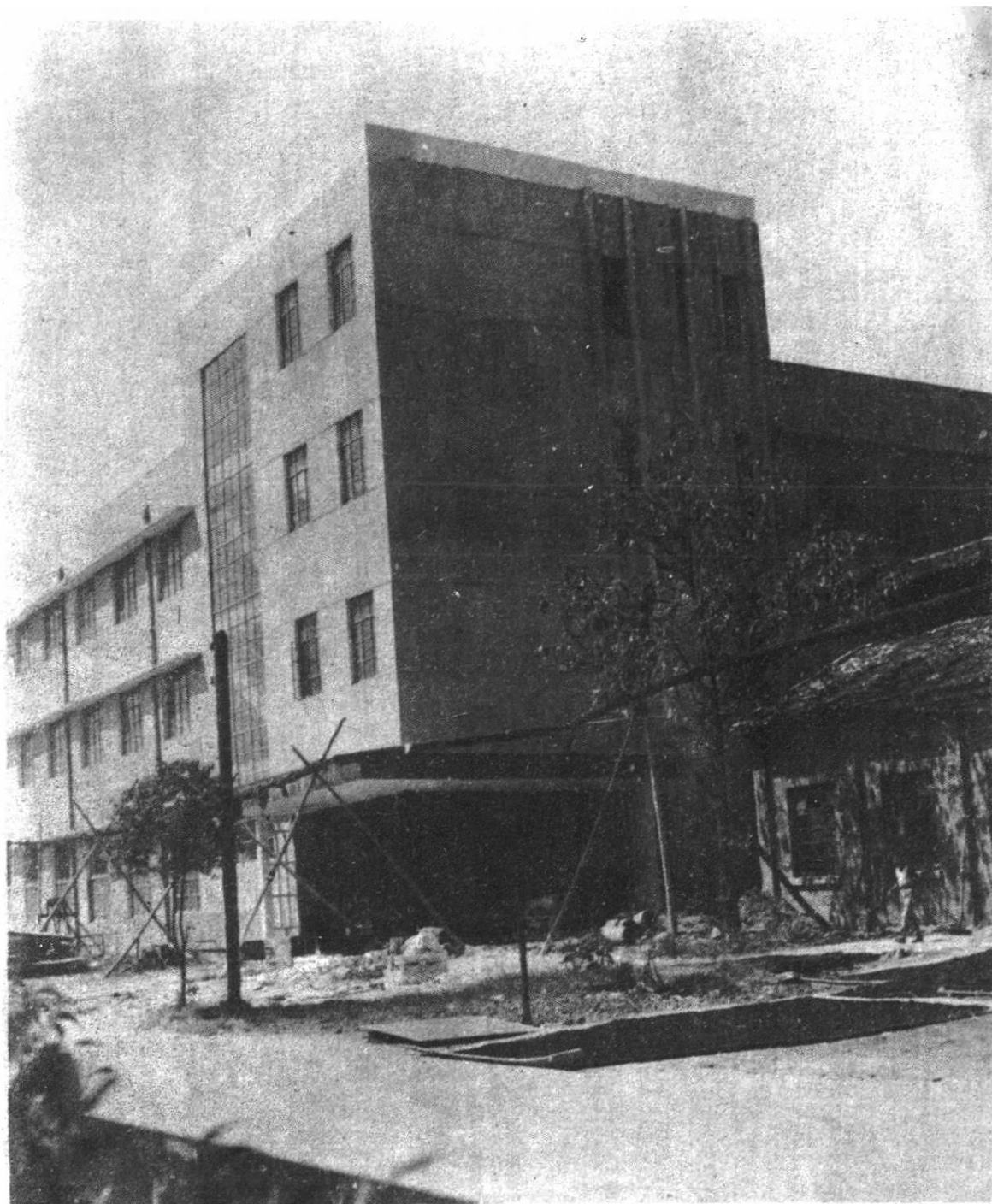
兴建的冻米糖车间即将竣工
