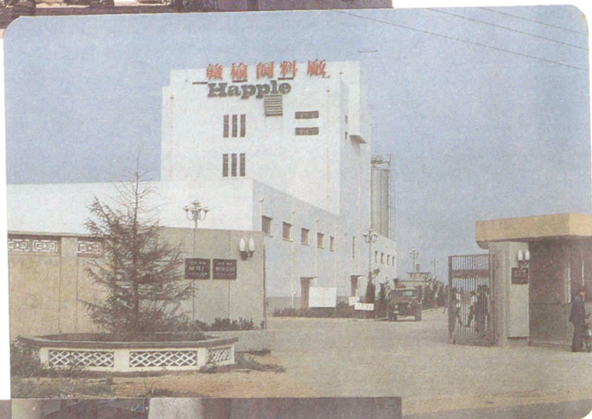
11. 赣榆饲 料厂厂房
