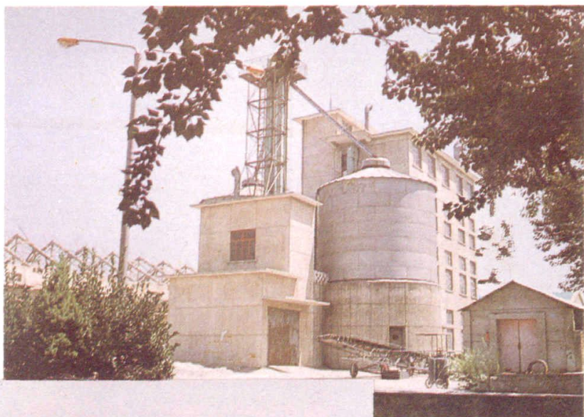
7. 新海粮 食仓库除杂 楼
